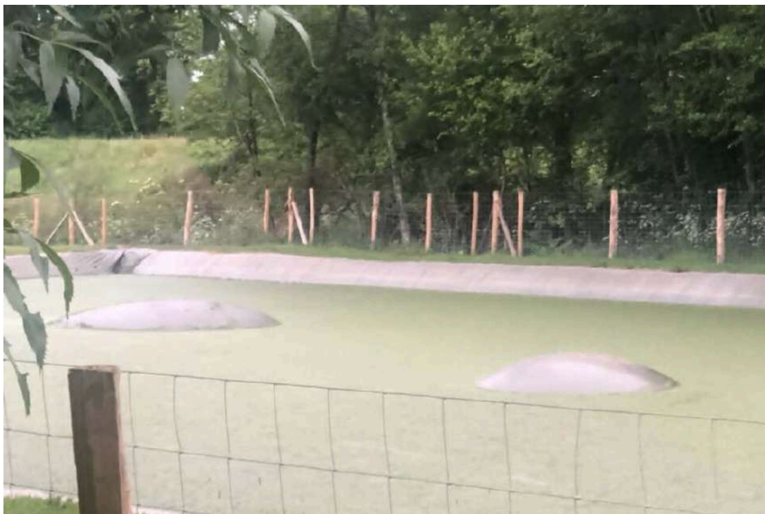
Des bulles de gaz remontent la bâche du fond des bassins. ©Le Courrier Vendéen
