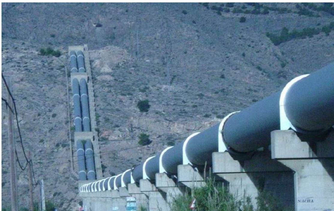
Imagen de la canalización del trasvase Tajo-SeguraEP
